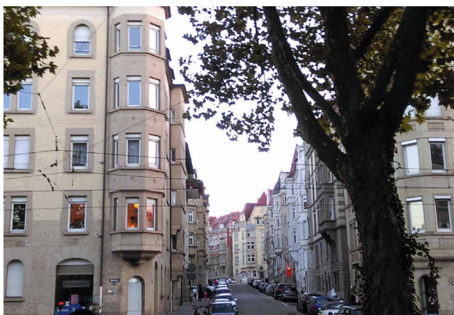
Abb. 1: Wohngebäude, die vor der ersten Wärmeschutzverordnung (WSchVO 1977) erbaut wurden, können durch Dämmung der Außenwände die Wärmeverluste in der Heizperiode mindern. Foto: M. Tuschinski
