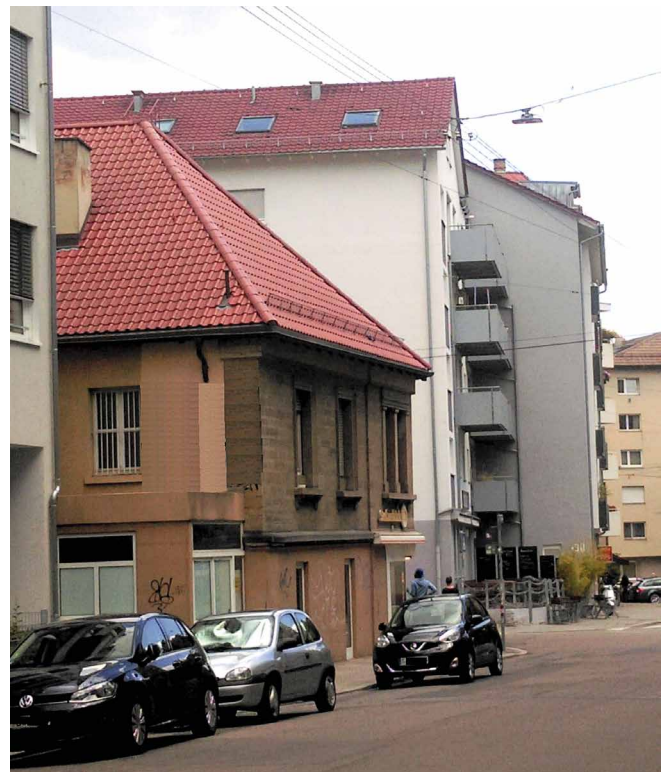
Abb. 1: Die EU-Gebäuderichtlinie fordert, dass der Fokus der energetischen Sanierung auf die schlechtesten energetischen Gebäude fällt. Dazu gehören Einfamilienhäuser, erbaut vor der ersten Wärmeschutzverordnung (WSchVO 1977). Foto: M. Tuschinski
