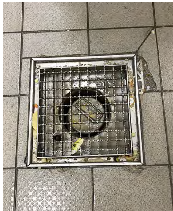
Abb. 5: Detail Bodenablauf mit Fliesenabschlusschiene aus Edelstahl
