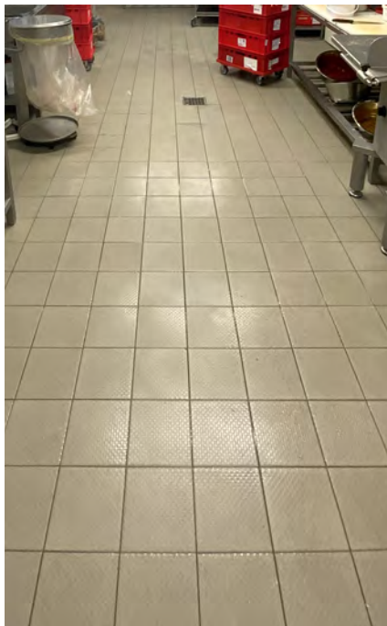
Abb. 3: Fliesenbelag in einer Fleischerei mit Bodenabläufen ...
