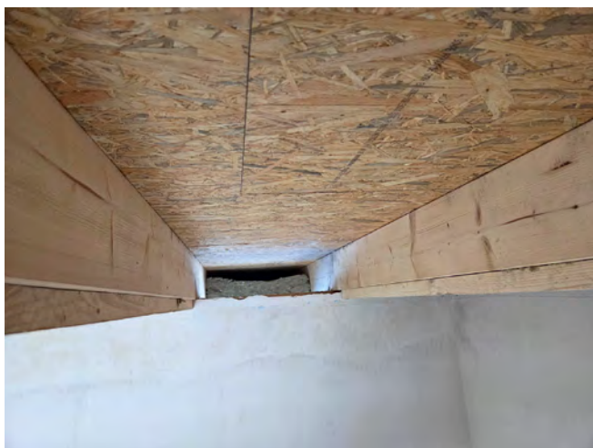
Abb. 2: Untersicht der Dachkonstruktion mit Zwischensparrendämmung und Holzwerkstoffplatten
