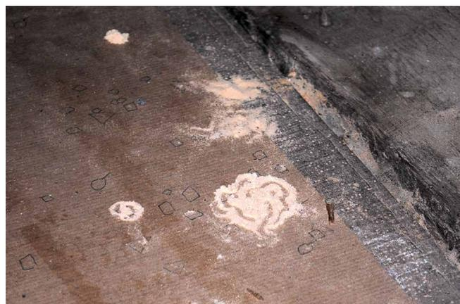
Abb. 3: Auswurf von Bohrmehl und Laufspuren von Buntkäferlarven auf Bodendielen
