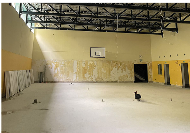
Abb. 10+11: Sporthalle und Nebenraum mit ausgebauter Fußbodenkonstruktion
