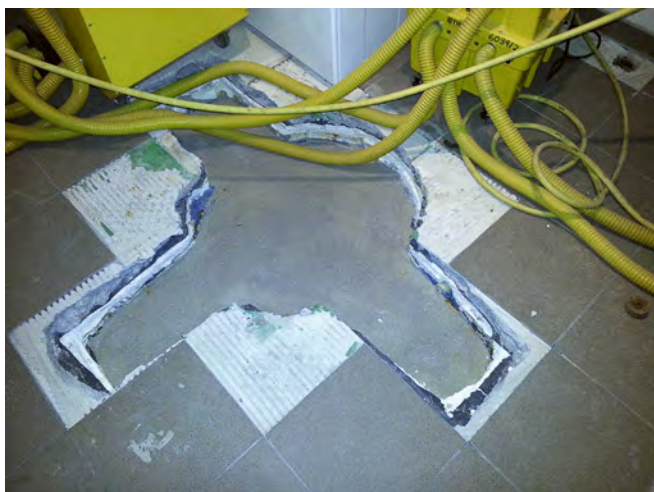
Abb. 5: Ausgebaute Hebeanlage [Quelle: P. Schewe]
