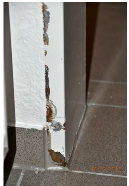
Abb. 2: Verrostete Türzargen [Quelle: P. Schewe]
