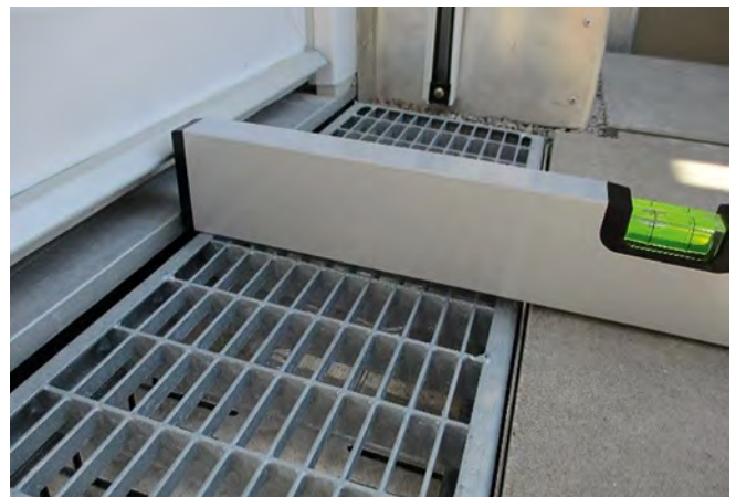
Abb. 1: Barrierefreier Terrassentüranschluss [Quelle: G. Göker]
